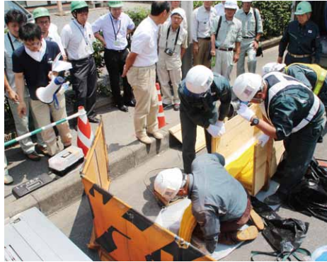
川口市内で行われた管更生工事現場
