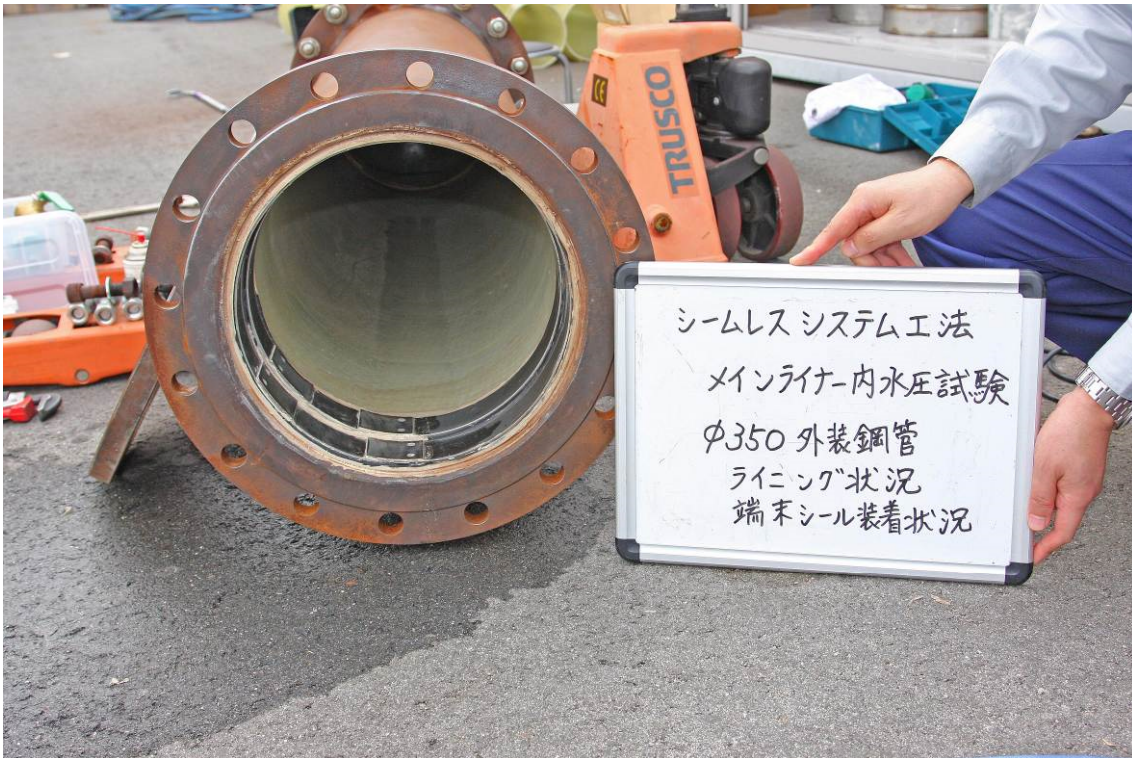
写真 - 1 管口状況
