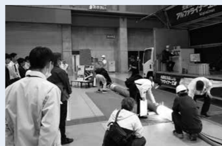
高松市でのデモ施工のようす
