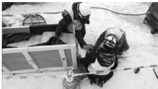
■写真-2 ライナー引込み状況
