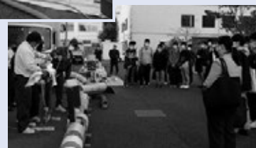
FRP光硬化取付管ライニング工法
