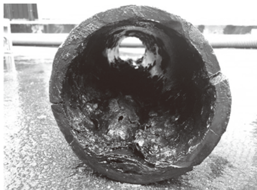
■写真1 実際に掘り上げたZパイプ
