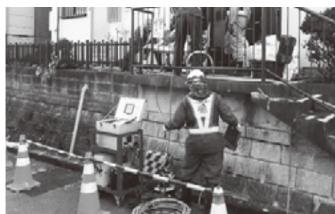
■写真4 取付管ライニング工法施工状況
