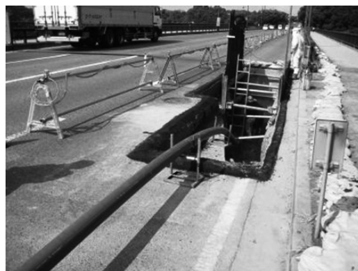
写真-2 水道用パイプインパイプ工法
