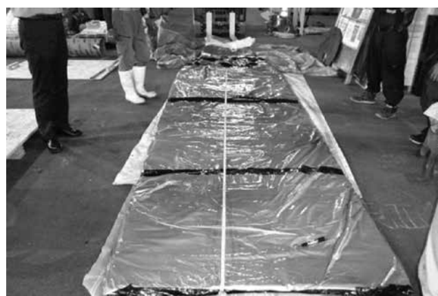
5mのFRP更生材
