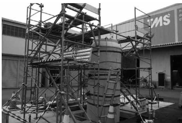
5m施工性試験状況
