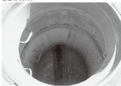
施工前のマンホール
