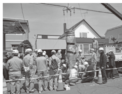
更生材の挿入
