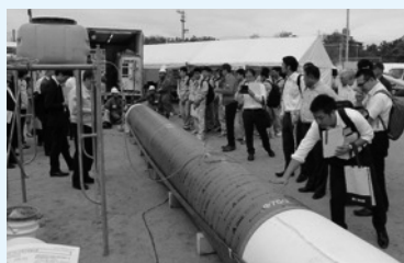
アルファライナー工法デモ施工
