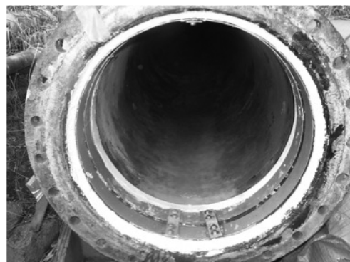
写真4 簡端リング装着 更生完了
