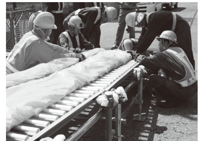
管内へ引き込み作業を行う
