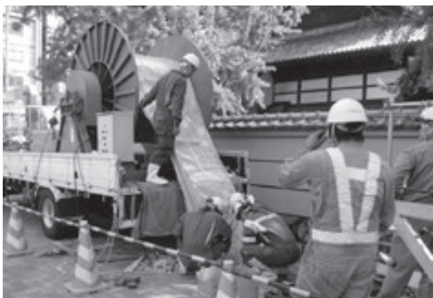
■写真4. 材料引込み状況
