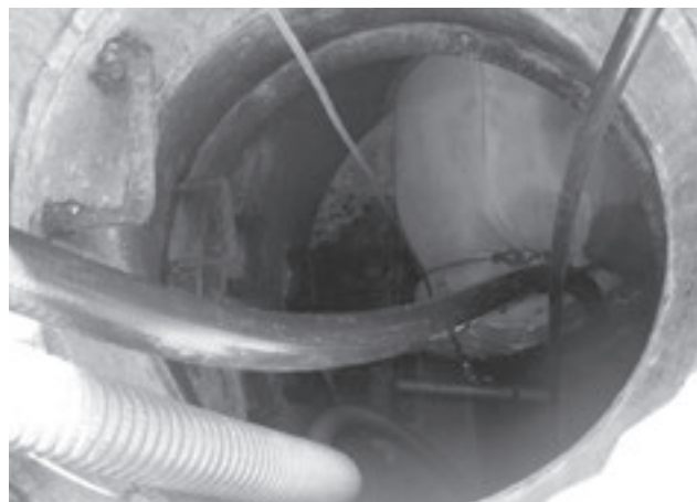
■写真7. 拡径状況
