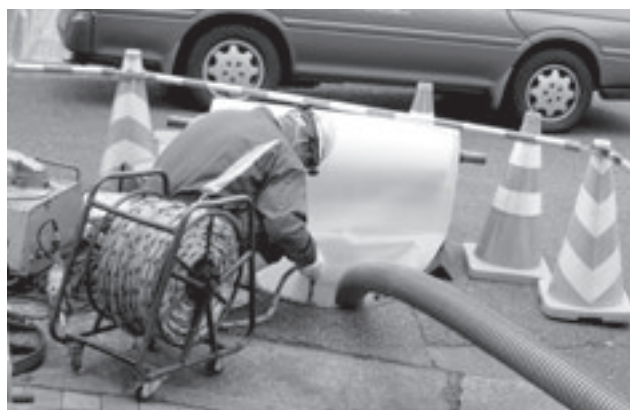
■写真3. スリップシート引込み状況
