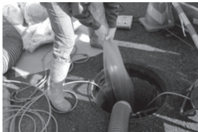
■写真9. インナーフィルム除去状況
