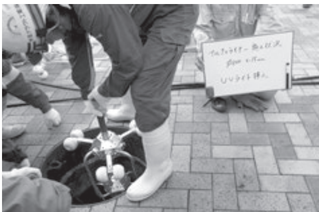
■写真5. 光照射装置の挿入状況
