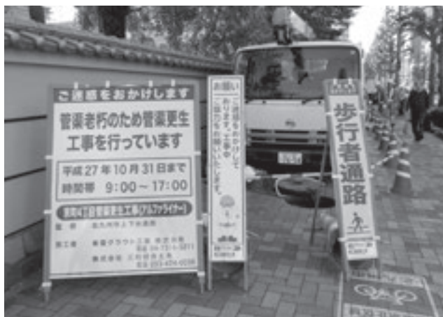
■写真1. 歩道内に施工帯を設置
