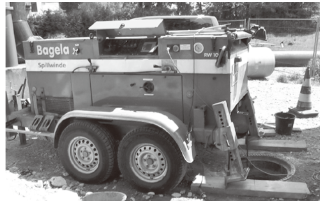
■写真10. 巨大な10トンウインチ
