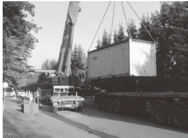
■写真7. クレーン車で降ろしています
