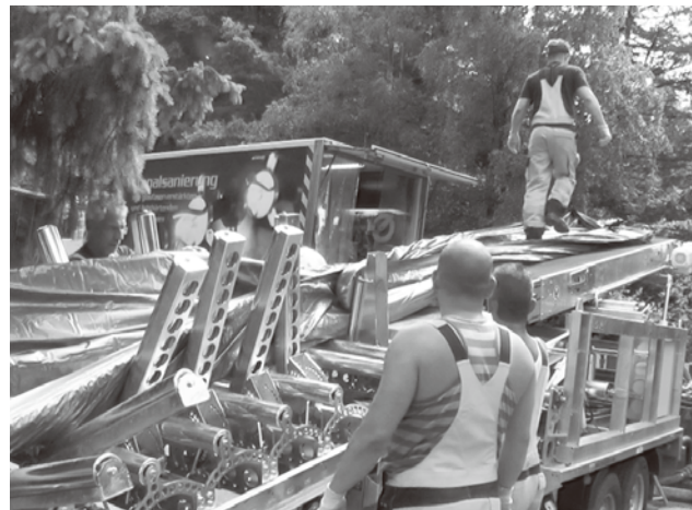
■写真9. ライナー搬送装置使用状況
