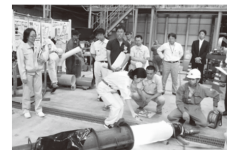
日本下水道事業団でデモ施工
