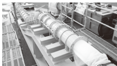
■ 図-2 模擬配管施工
