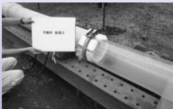
既設管にフェルト材を敷く
