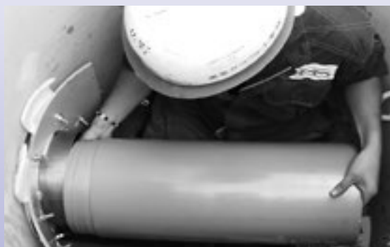
新設するファイン管を挿入
