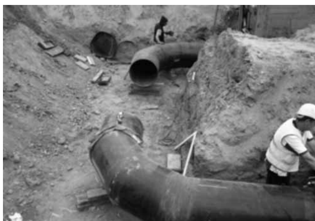
■写真2 U字型バイパス管設置状況
