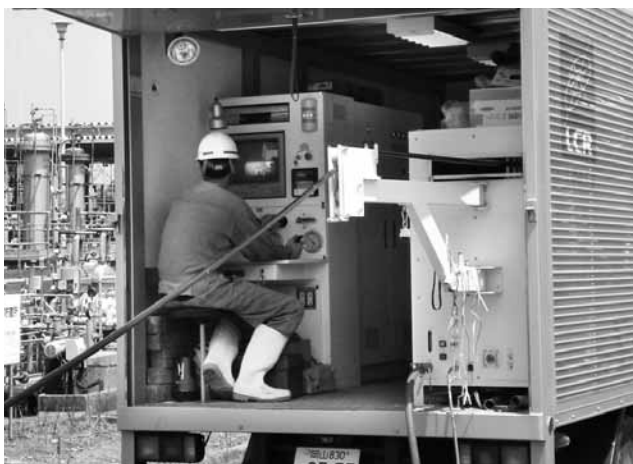
■写真2 光硬化工法施工装置車
