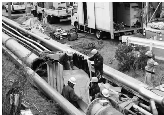
■写真1 工場内地上配管(内圧管)の更生
