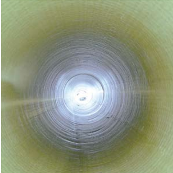
施工後の状況
