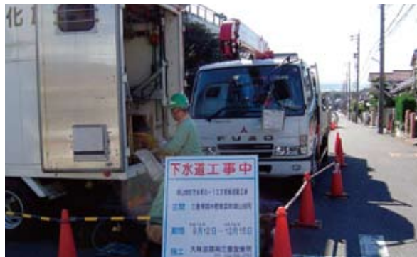
東員町施工现场
