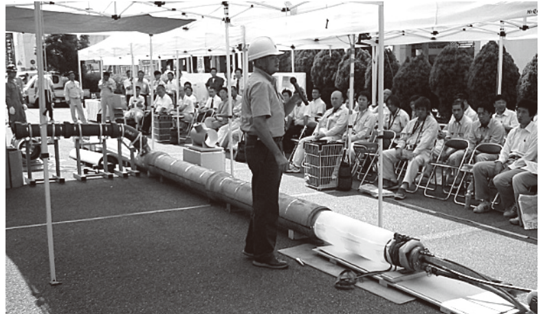
今治市でのデモ施工
