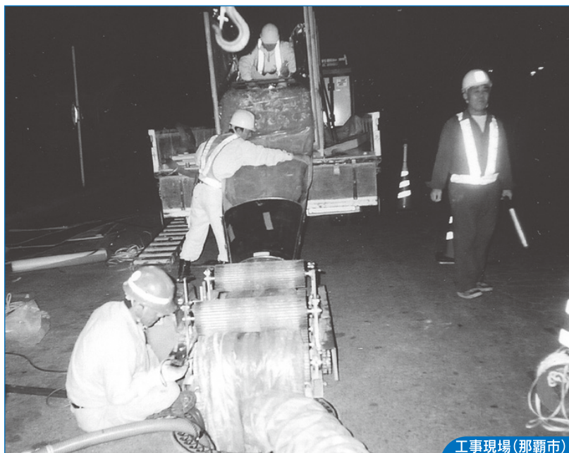
工事現場(那覇市)
